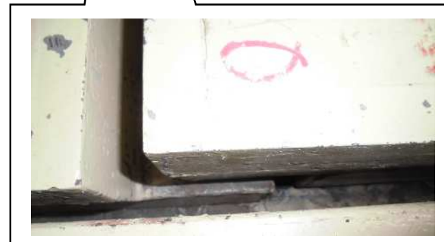
水の流出を考慮する平板間の隙間
