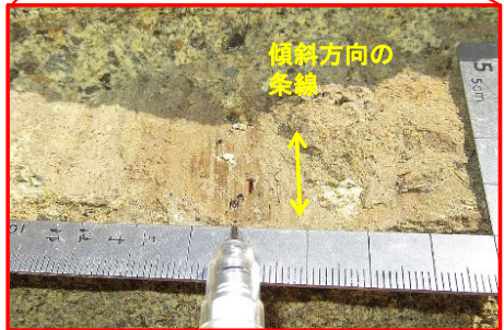
pd系弱面d ・強風化部 ・走向・傾斜: N8° W, 29° E ・傾斜方向の明瞭な条線有り(プランジ角28° E)
