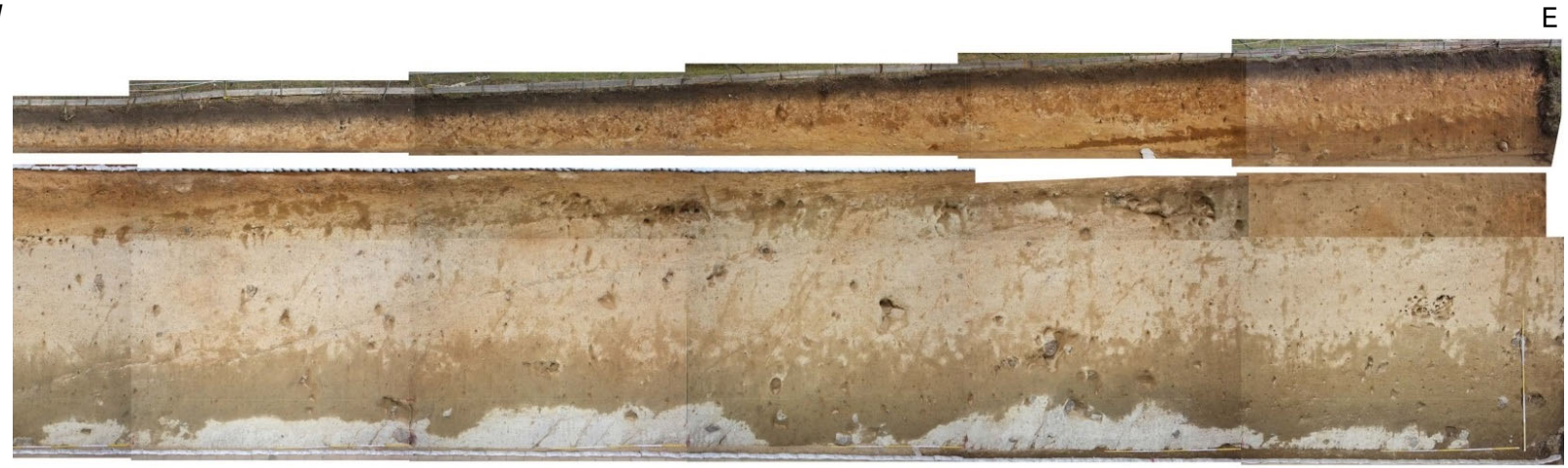
法面① 写真
