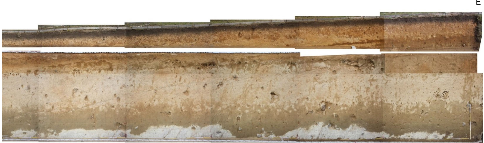
法面① 写真
