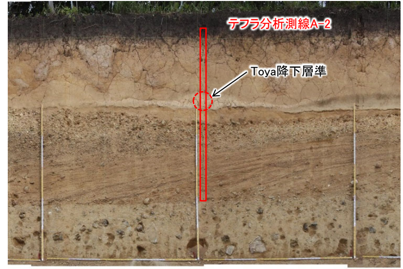
法面④詳細画像
