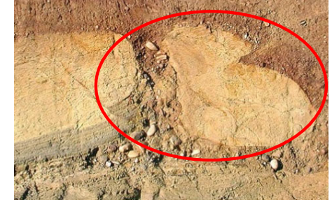
④ 5m西方法面
