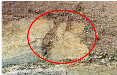
⑤ 6.5m西方法面
