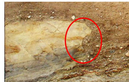
⑩ 14m西方法面
