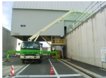
第4図 埋設設備内への充填材充填
