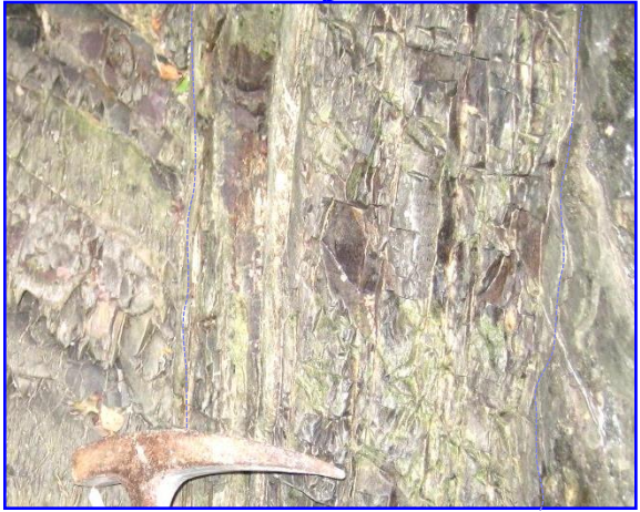
泥岩の層理面は固結，密着している。
