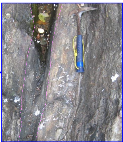
(拡大写真) 凝灰岩と礫岩の境界は固結，密着している。
