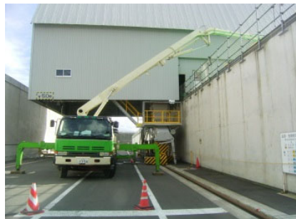
第4図 埋設設備内への充填材充填
