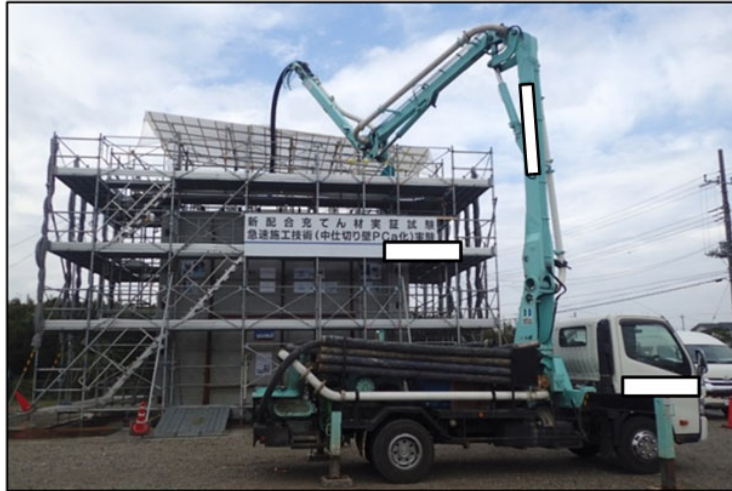
第 23 図 モルタル打設方法
