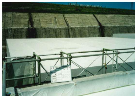
仕上げ材吹付け
