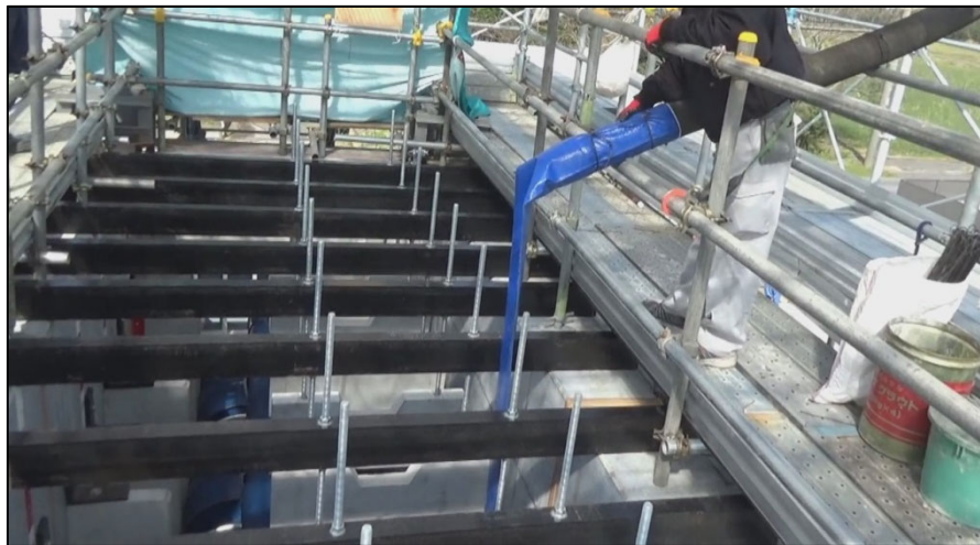
第 25 図 充填モルタル打込み状況
