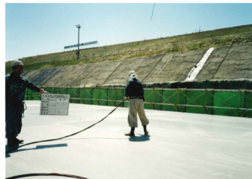
防水材吹付け
