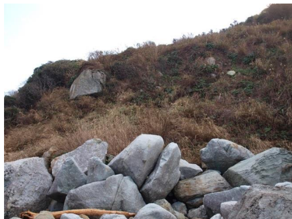
基盤岩である流紋岩質火砕岩が堅硬な転石として分布する
