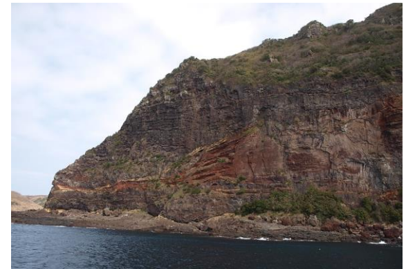
b. 岩盤崩壊箇所中央部の海食崖
