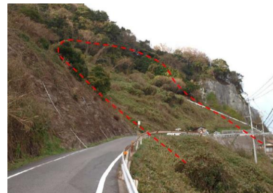
ブロック上部～中央部の斜面状況
