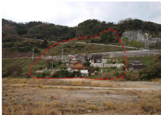
地すべりブロック全景
