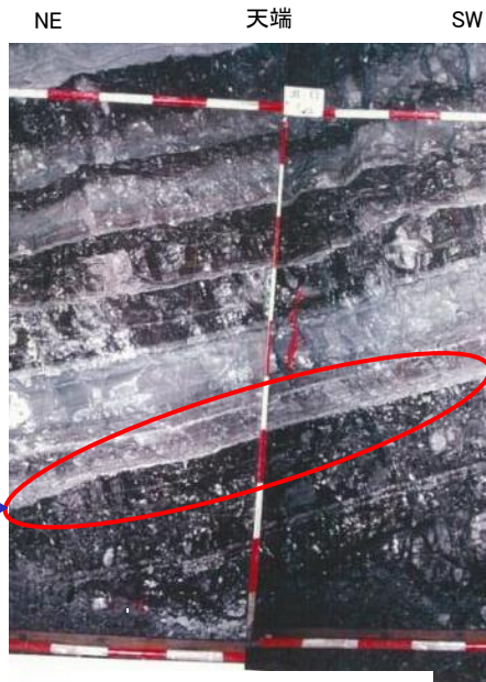
試掘坑写真(平成9年撮影)
