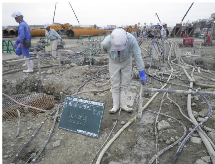
薬液注入工 状況写真(2011年撮影)
