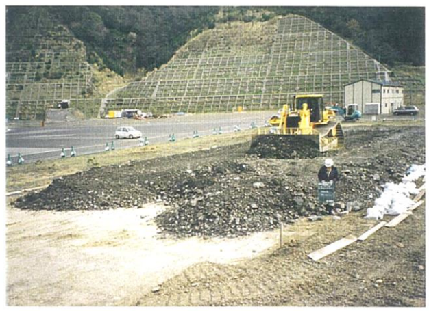
巻き出し整地状況
