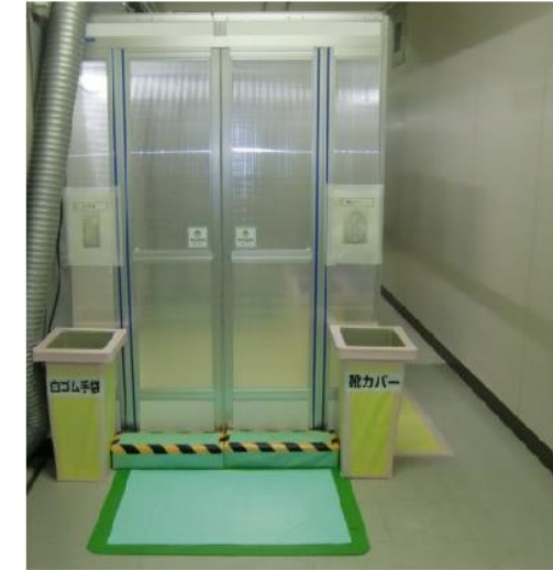
第6図 チェンジングエリアの外観
