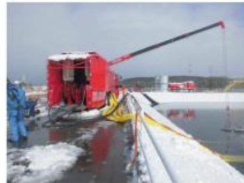
水中ポンプ設置の状況
