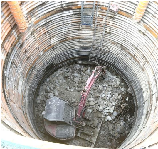
第 7. 4. 2-22 図 掘削状況写真
