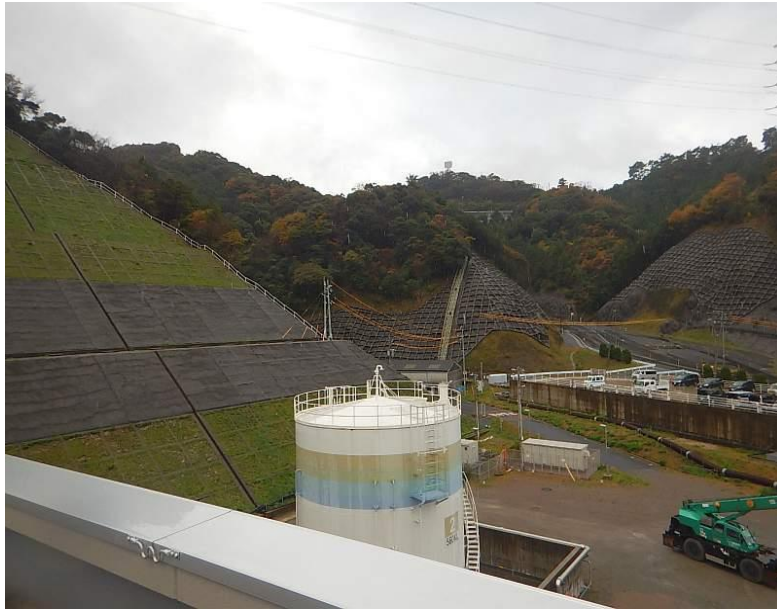
(例) 構内監視カメラ (ガスタービン発電機建物屋上) にて 輪谷貯水槽 (西1 / 西2) の南側方向
