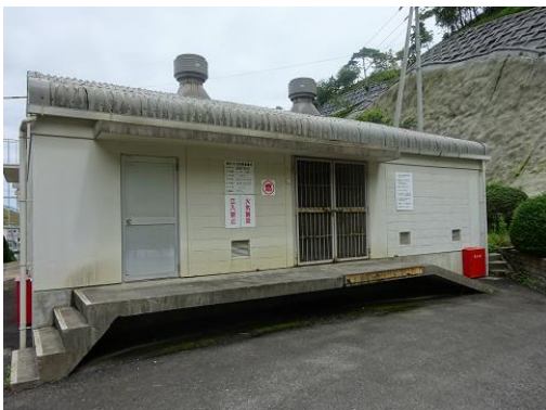
高圧ガス貯蔵所
