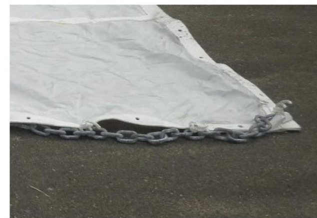
端部拡大写真 (重り (チェーン))
