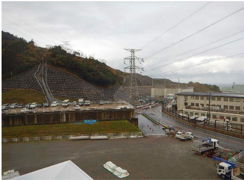
(例) 構内監視カメラ (ガスタービン発電機建物屋上) にて 輪谷貯水槽 (西1 / 西2) の北側方向
