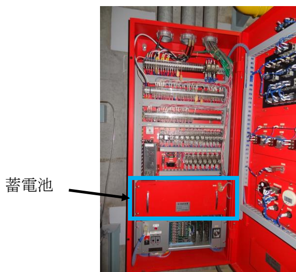
第41-1-24図 消火設備の電源確保の概要
