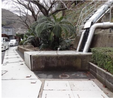
第 41-1-28 図 屋外消火配管への保温材設置状況
