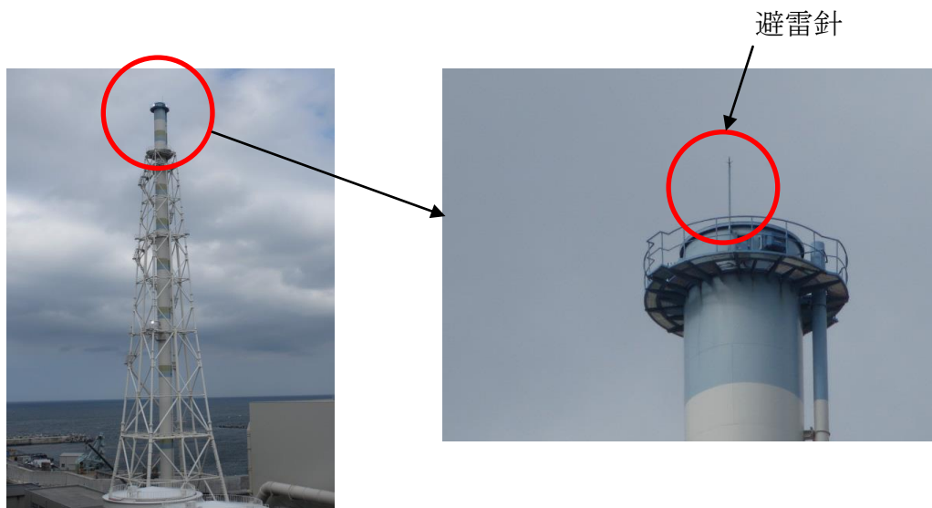
第41-1-12図 避雷設備の設置例 (排気筒)
