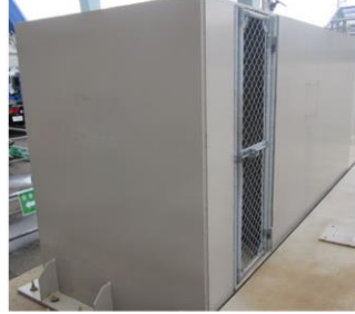
②0F ケーブルダクト吸気口, ③竜巻防護対策
