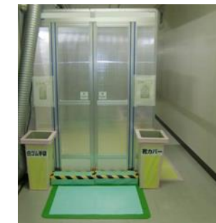
図 3.3-6 チェンジングエリアの外観
