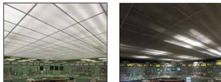
(通常点灯状態) (直流非常灯点灯状態)
