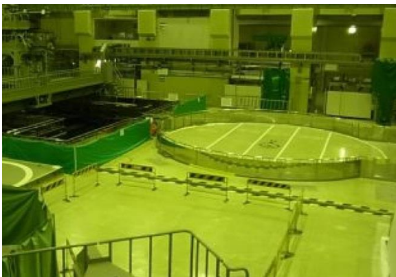
原子炉建物原子炉棟4階の床面上設備
