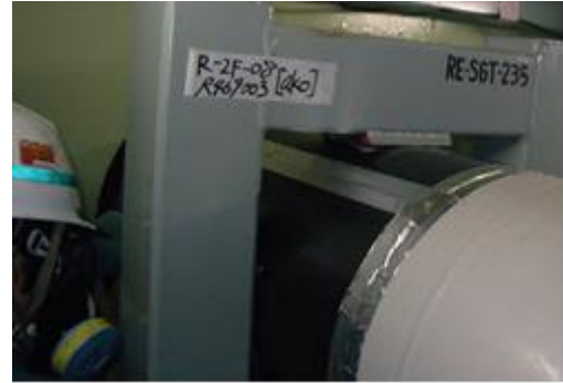
② ゴムシート貼付
