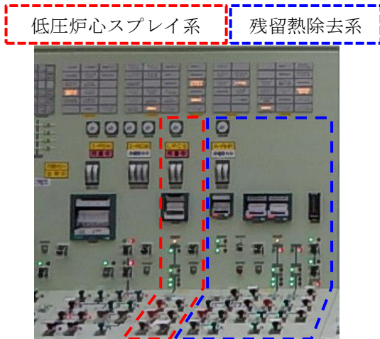
第 2.4.1 - 4 図 系統区分による配置例
