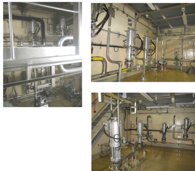
HCW バルブ室の可燃物の状況 (可燃物なし)
