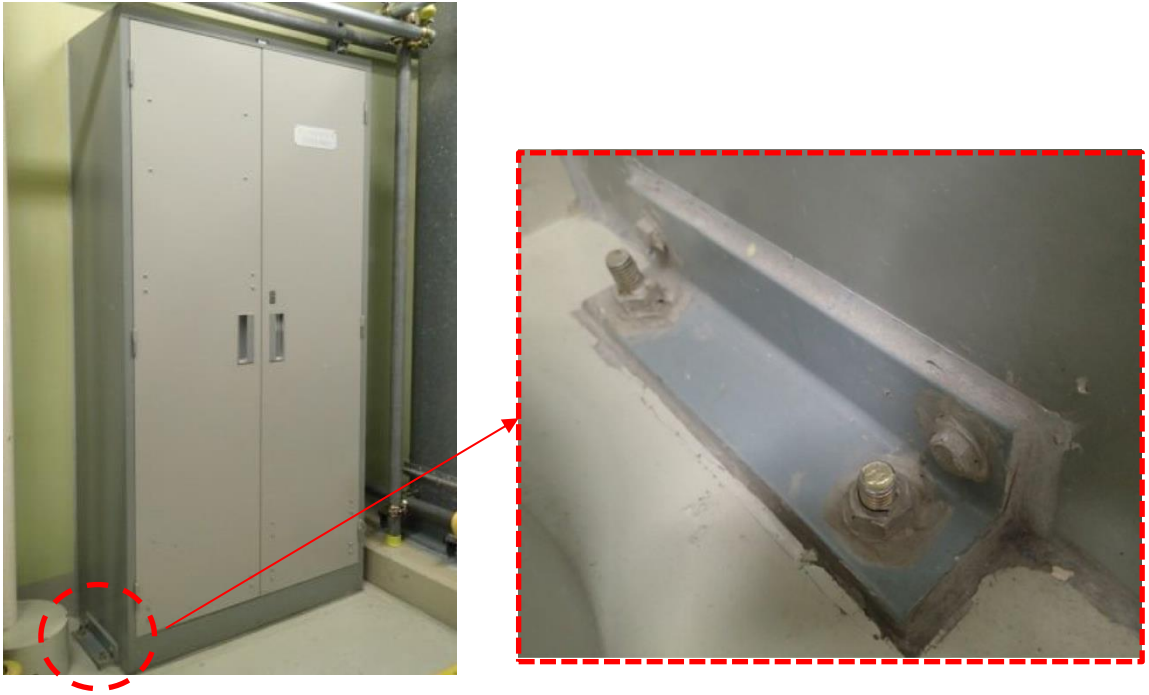
図 3-2 アクセスルートの固縛処置例（原子炉建物 R-1F-01-1N）
