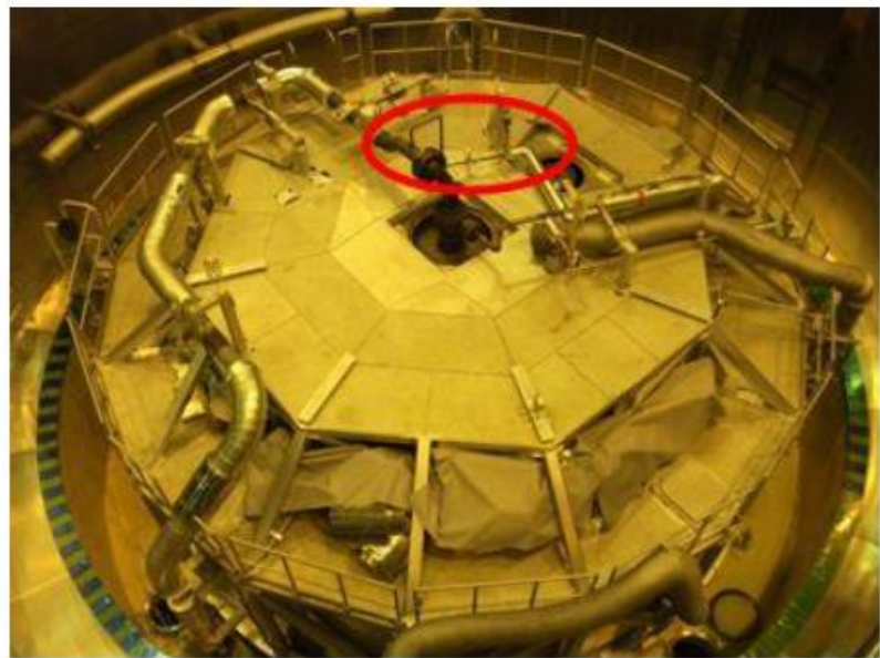
第 1-9 図：ベント配管の設置例
