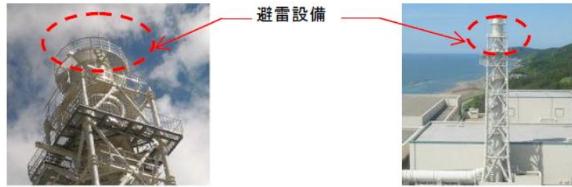
第 1-16 図：避雷設備の設置例（主排気筒）
