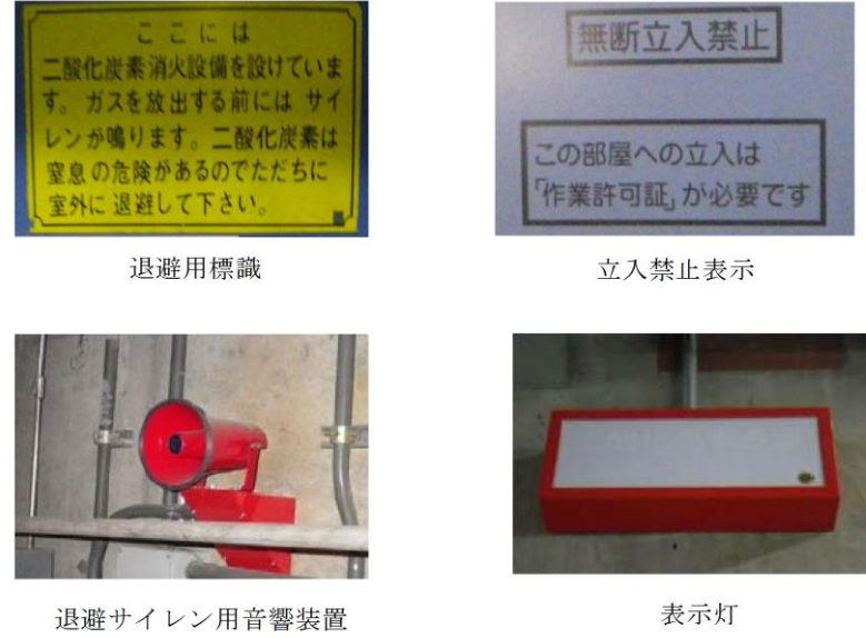
第1-32図 二酸化炭素自動消火設備（全域）の退避警報装置の例
