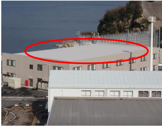
177 4号館管理事務所
