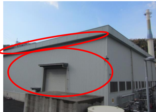
165 3号炉補助ボイラ
