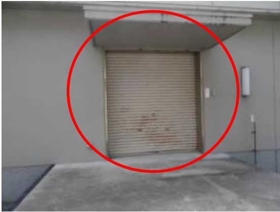
70 危険物屋内貯蔵所東側シャッター
