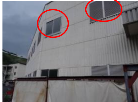
89 5号倉庫給気用格子，ガラス窓
