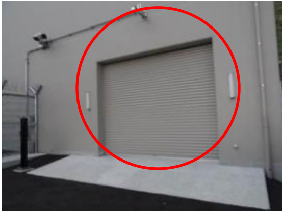
92 44m版事務所東側シャッター
