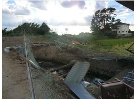
写真 5.1.16 フェンスの被害
