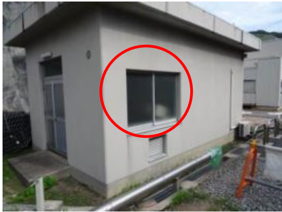
72 汚水処理施設ガラス窓
