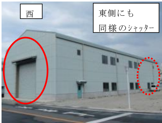
125 倉庫西，東側シャッター
