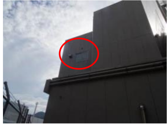
69 サイトパンカ建物ガラス窓（2）
