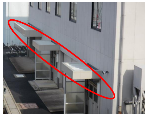
176 3号館管理事務所
