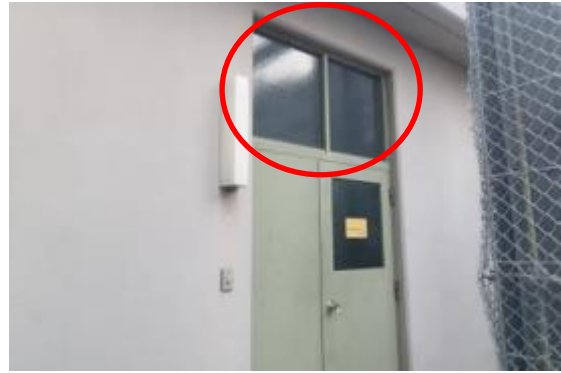
97 2号開閉所ガラス窓
