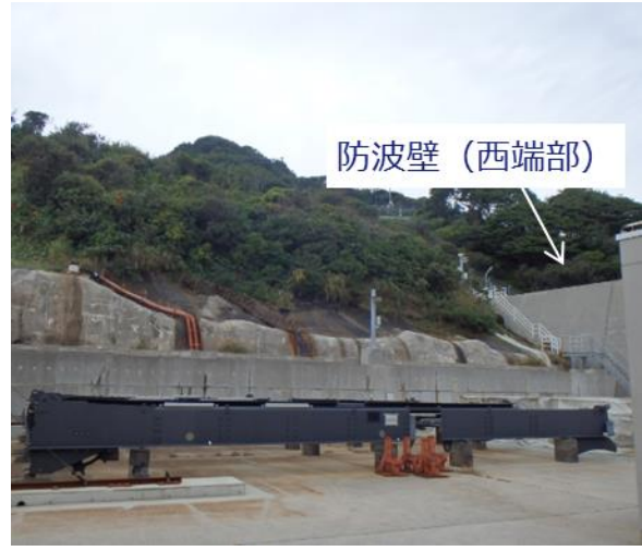
図2-21 防波壁西端部 状況写真
