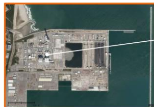
写真④ 茨城港常陸那珂港区周辺状況
