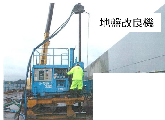
施工状況（造成工）
