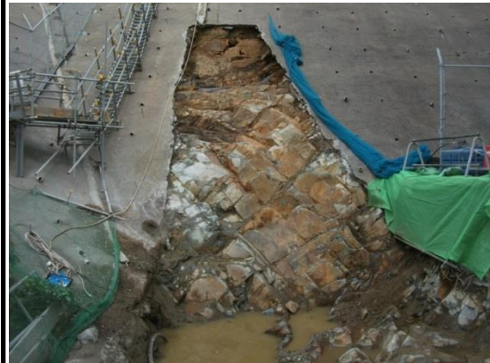
防波壁東端部 岩盤露出状況
