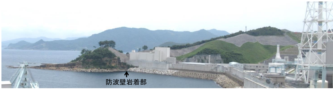
図 2 - 8 ( 1 ) 防波壁 ( 東端部 ) 露頭状況 P1 防波壁 ( 東端部 ) 全景 岩着部は尾根の先端を開削した法面に位置する。
