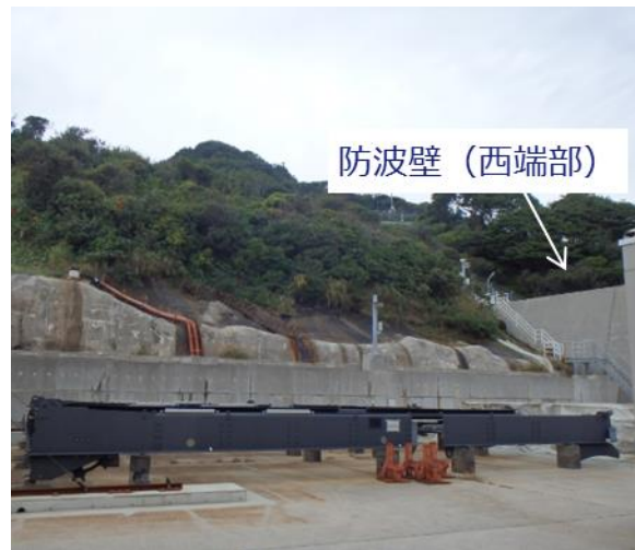
図 2 - 21 防波壁西端部 状況写真
