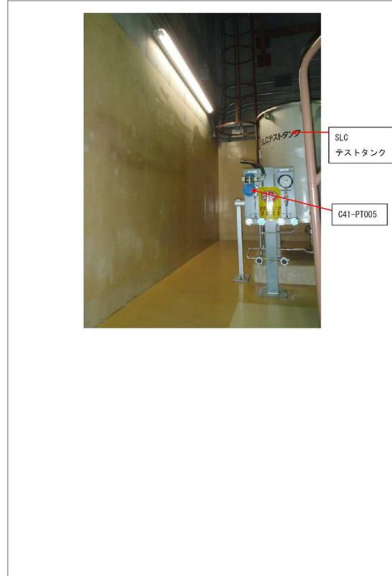
現場状況写真 等
