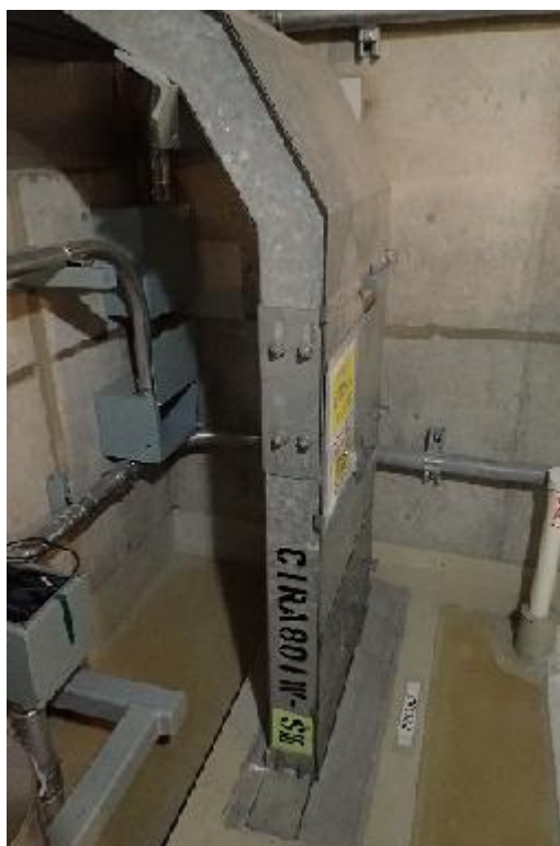
第2図 ケーブルトレイ床貫通部外観
