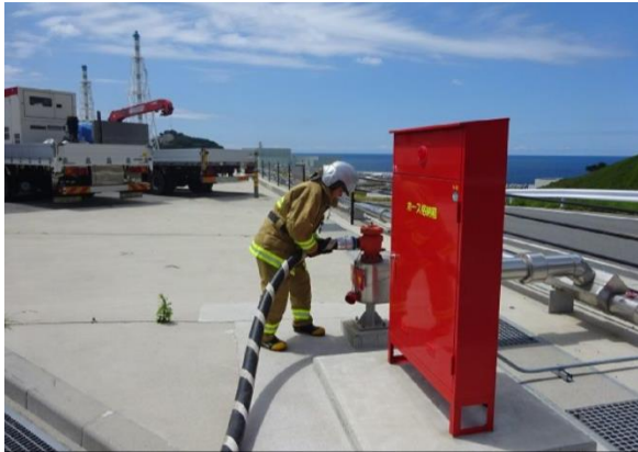
写真1 消火栓接続
