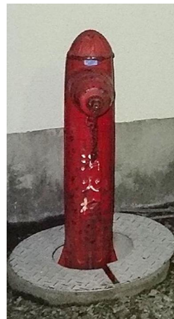
第2-2図 不凍消火栓外観
