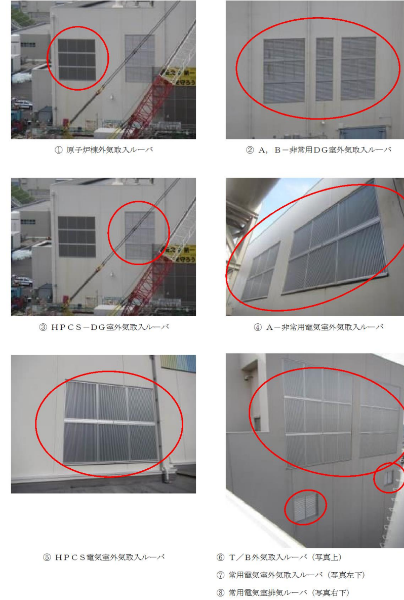
図3-1 外気取入ルーバの外観写真 (1 / 2)
