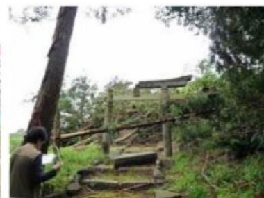
樹木の折損と鳥居の被害
