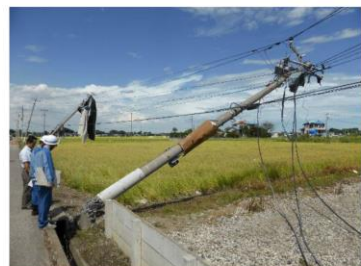
電柱の倒壊
