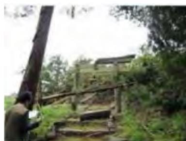
倒木の折損と鳥居の被害
