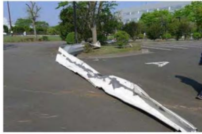
飛散した鋼板製屋根材
