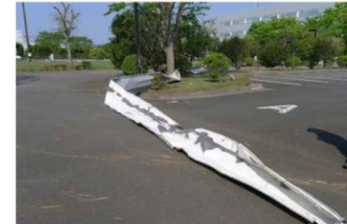
飛散した鋼板製屋根材
