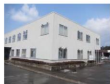
④-11 窓ガラス
