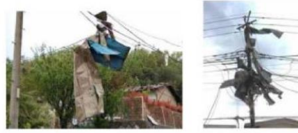
電線等に引っ掛かった飛来物 (鋼板製屋根材)
