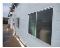
④-12 窓ガラス
