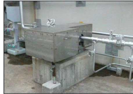
図 5-2 燃料移送ポンプ外形写真
