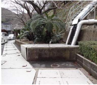
第 1 -32 図 屋外消火配管への保温材の設置状況
