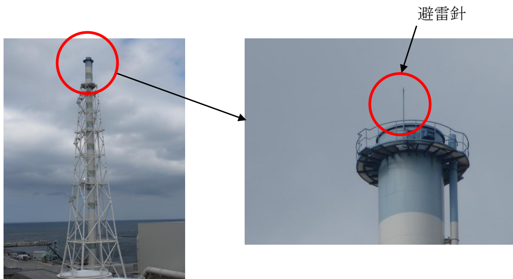
第1-15図 避雷設備の設置例（排気筒）
