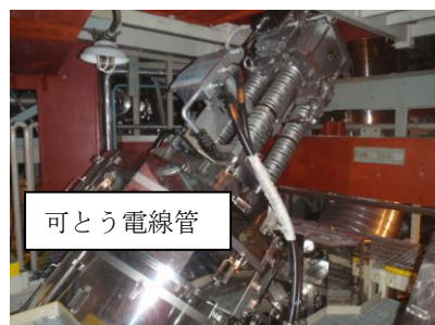
機器へのケーブル取合い (主蒸気内側隔離弁との取合い)
