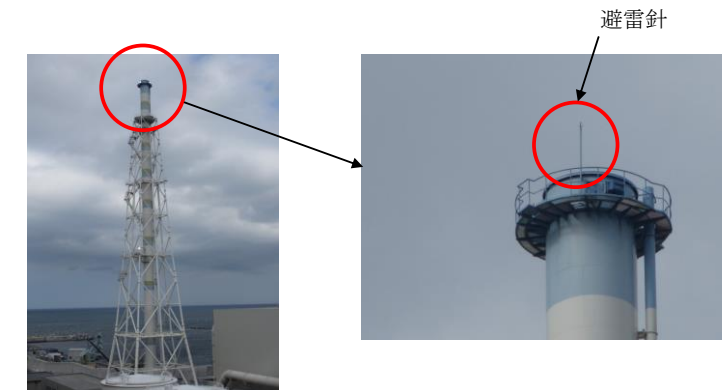
第 1-15図 避雷設備の設置例（排気筒）
