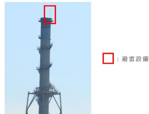
第1-16図 排気筒の避雷設備
