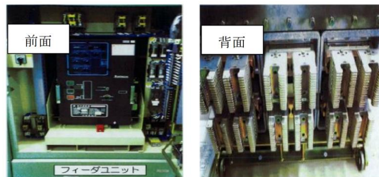
第1-14図 気中遮断器外観
