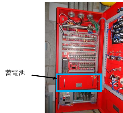
第 1-28 図 消火設備の電源確保の概要
