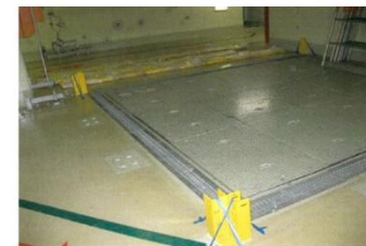
支柱レールの取付状況
