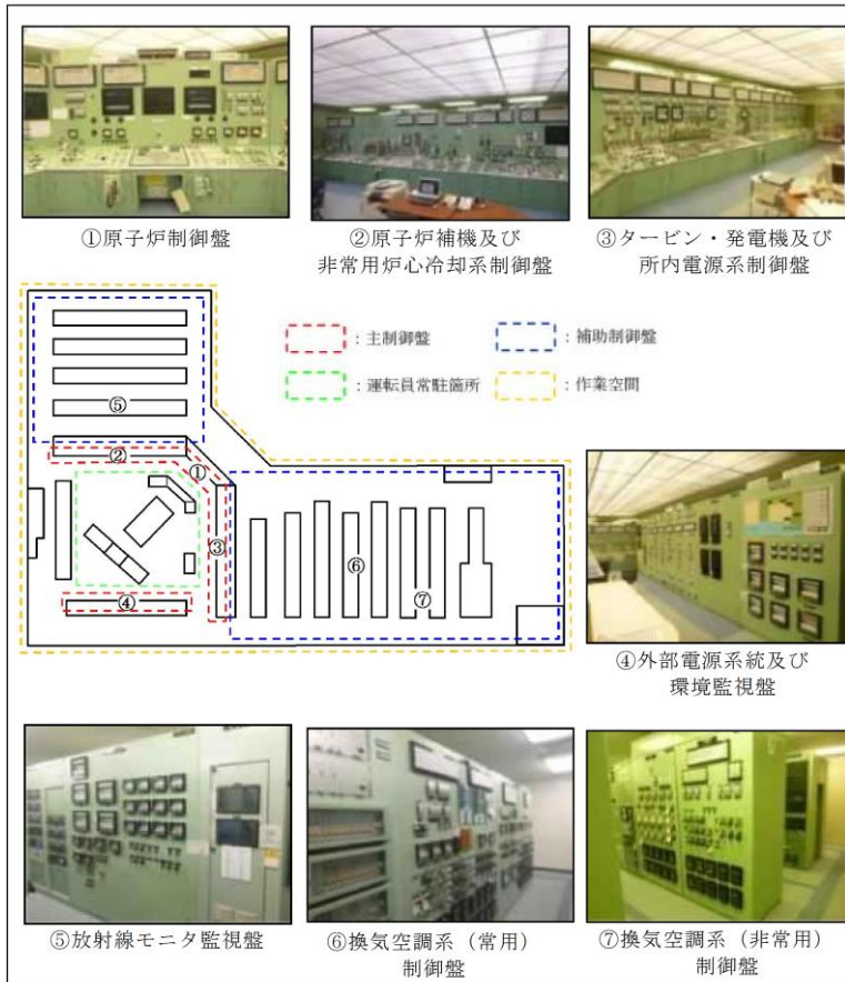
第2.4.1-1 図 中央制御室の制御盤配置
