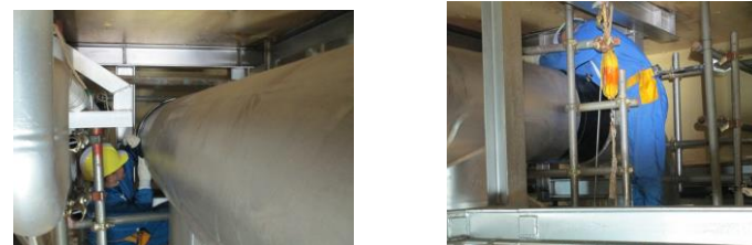
第2図 狭隘部作業状況
