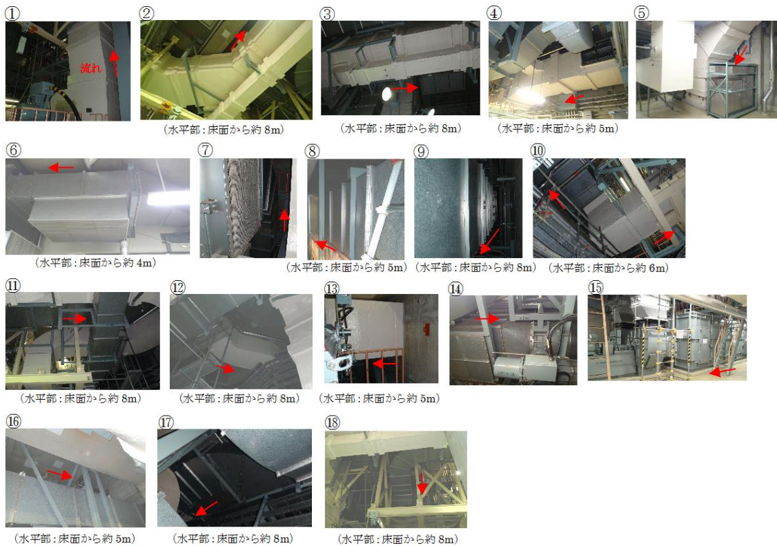
別紙図 1-9-2-2 ダクト敷設状況
