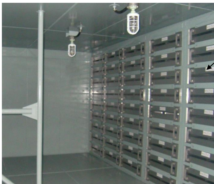
フィルタ（非常用）取付状態
