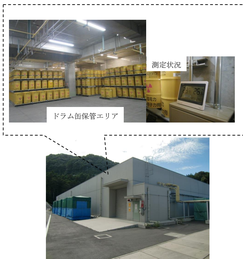
第2図 建物内温度の測定状況（固体廃棄物貯蔵所）
