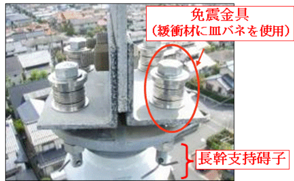
第 2. 2. 4-10 図 免震対策の施工状況
