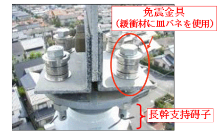
第 2.2.4-10 図 免震対策の施工状況
