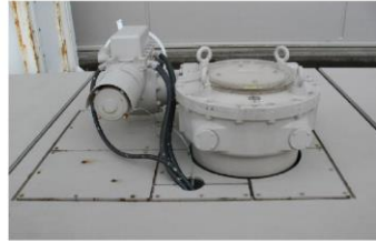
②0F ケーブルダクト吸気口, ③竜巻防護対策
